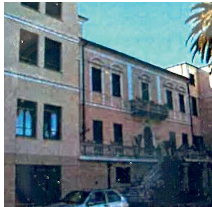
La palazzina “Scuola Infermieri” del Santa Corona di Pietra Ligure
