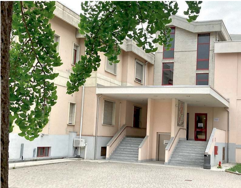
A Cairo proseguono i lavori per realizzare l'Ospedale e la Casa di Comunità
