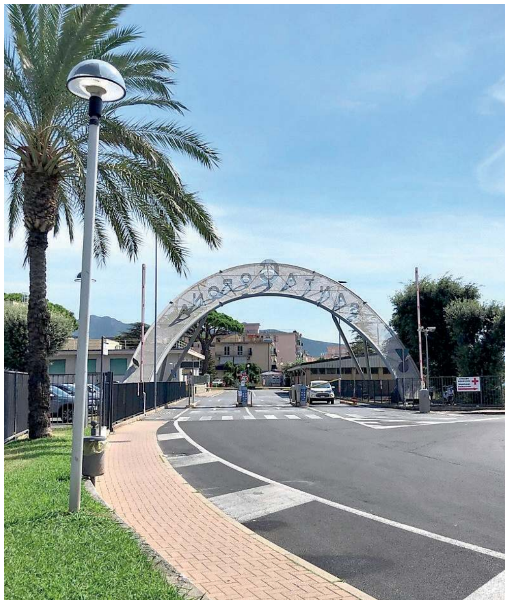
L'ingresso dell'ospedale Santa Corona di Pietra Ligure
