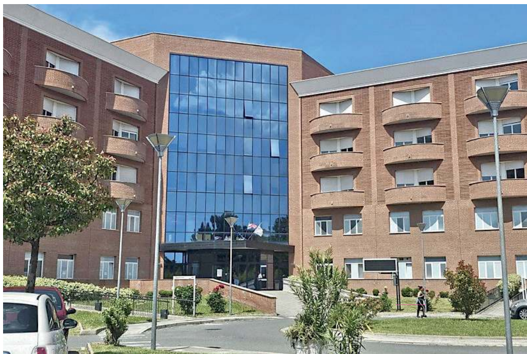
Al Santa Maria di Misericordia sono iniziati i lavori per creare l'Ospedale di Comunità
