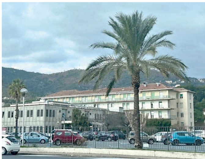
Il padiglione chirurgico del Santa Corona in via di ristrutturazione
