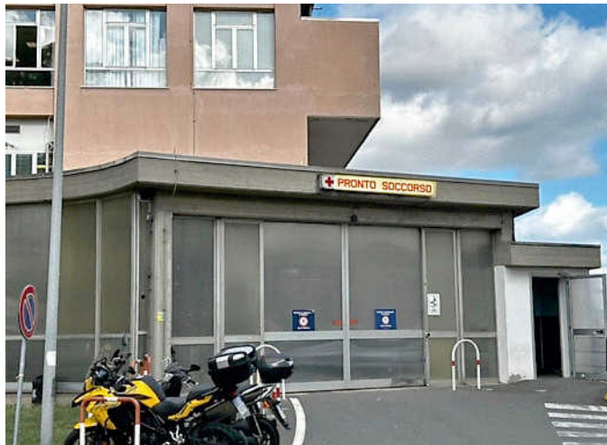
L'entrata del Pronto soccorso dell'ospedale San Paolo di Savona
