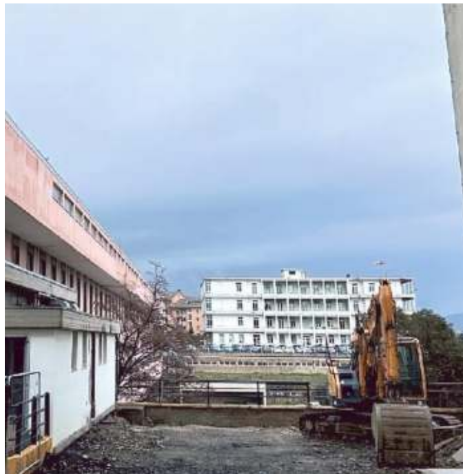
Il cantiere al San Paolo per la realizzazione del tunnel
