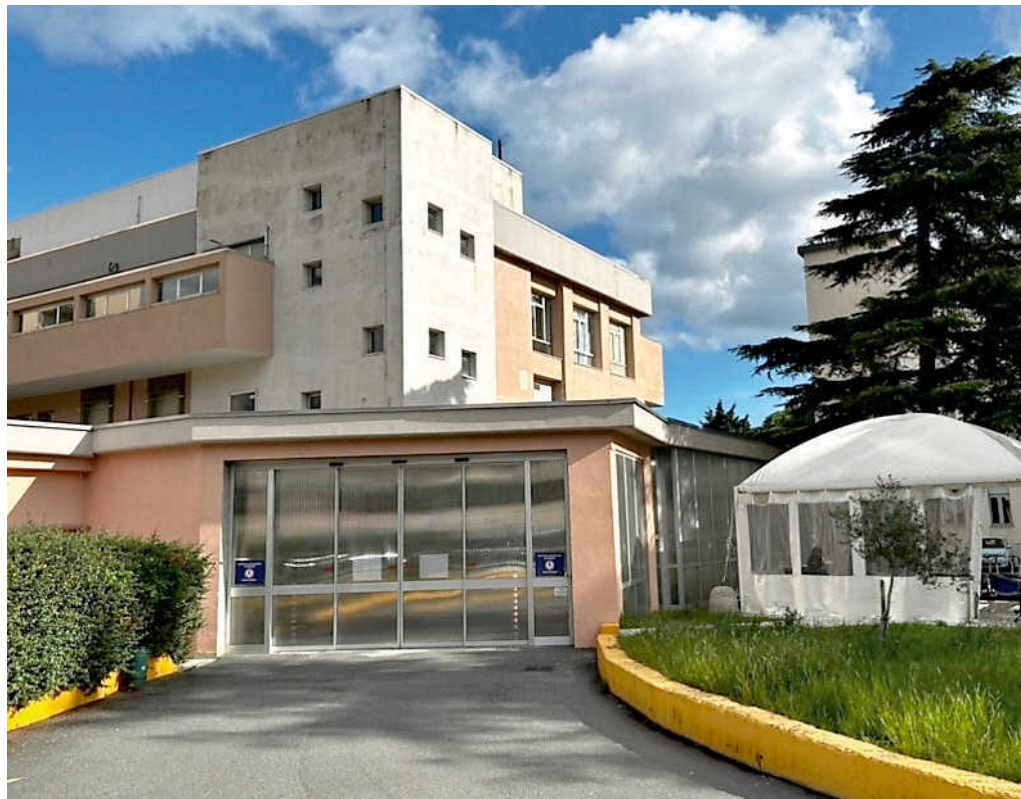
L'entrata del Pronto soccorso dell'ospedale San Paolo di Savona
