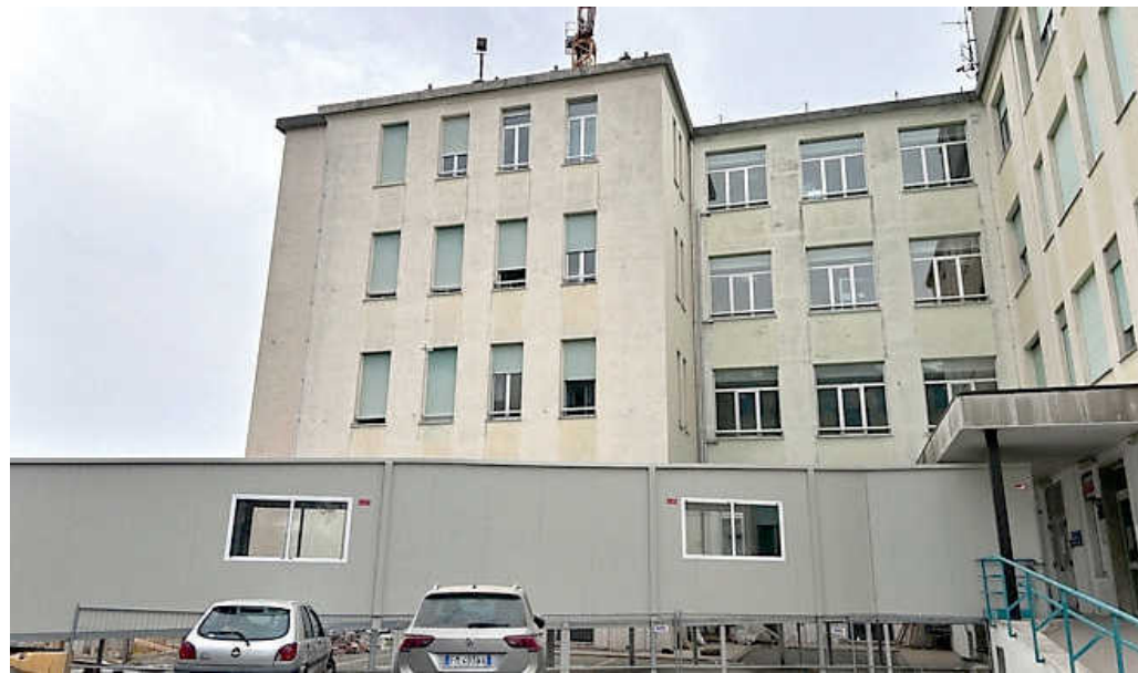
Il cantiere per la costruzione del collegamento tra Pronto soccorso e il padiglione Astengo
