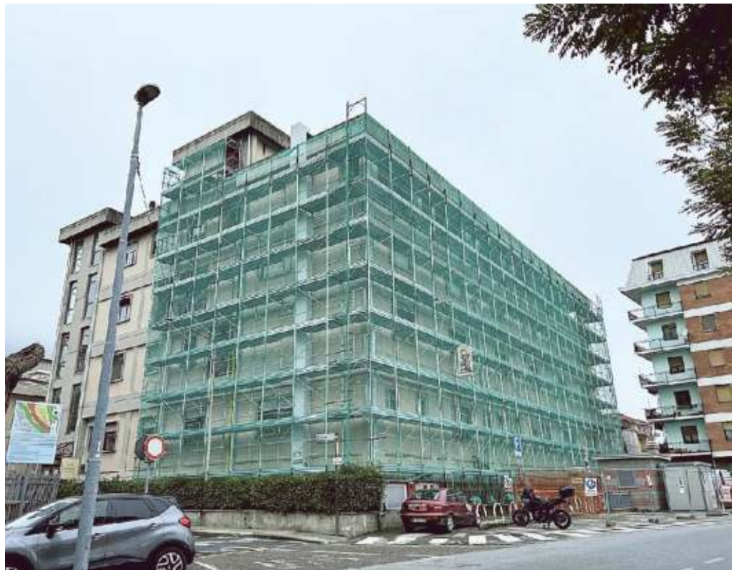
Lavori in corso all'ospedale San Giuseppe di Cairo
