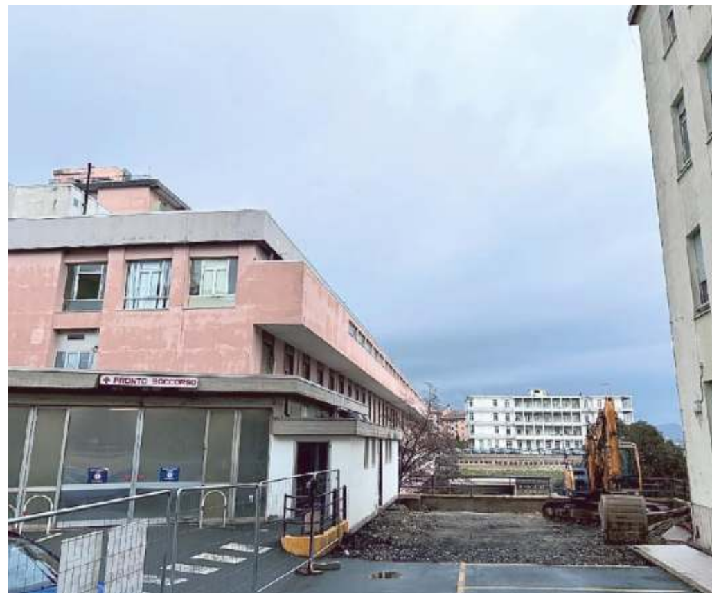
Ruspe al lavoro a Valloria: l'ingresso del pronto soccorso è stato trasferito sul lato monte del monoblocco
