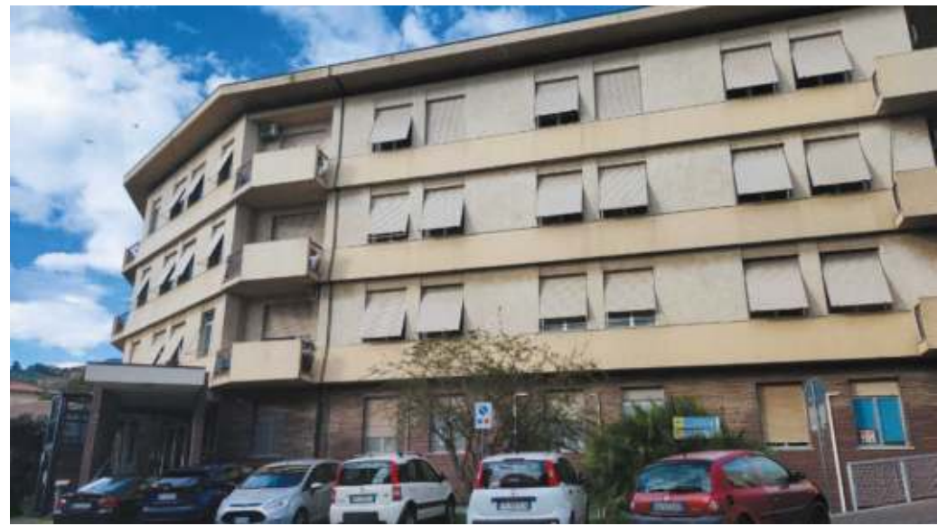
Il padiglione Negri dell'ospedale Santa Corona di Pietra Ligure in fase di dismissione
