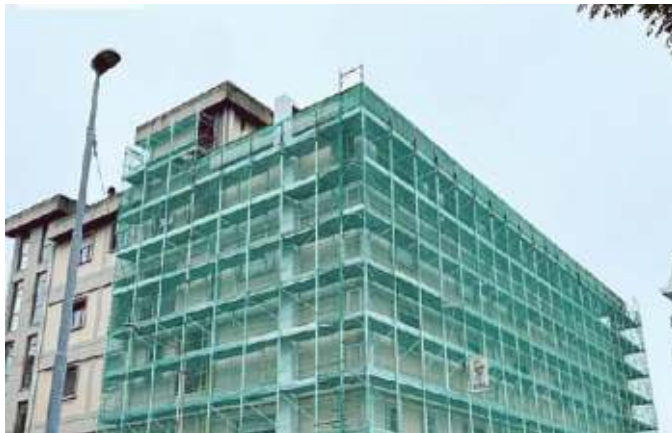
L'ospedale San Giuseppe di Cairo fasciato dalle impalcature
