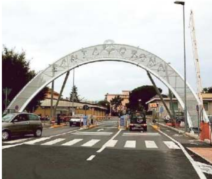
L'ingresso dell'ospedale Santa Corona di Pietra Ligure
