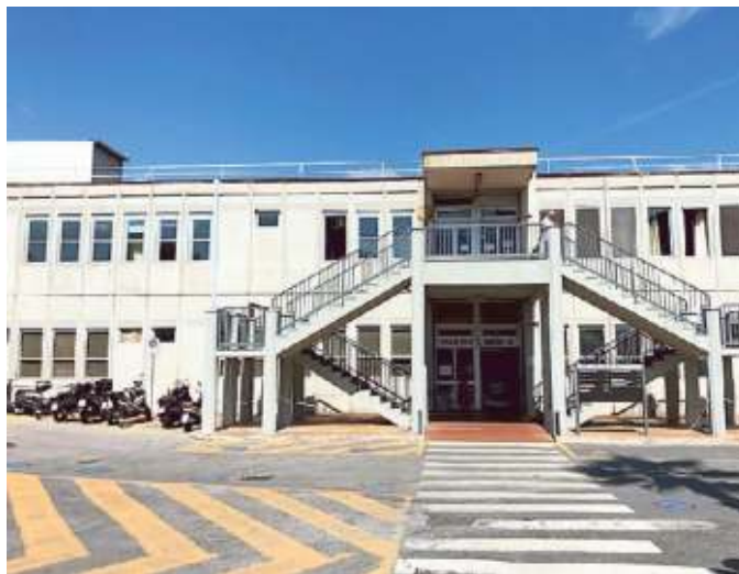
Il padiglione Piastra dei servizi del Santa Corona
