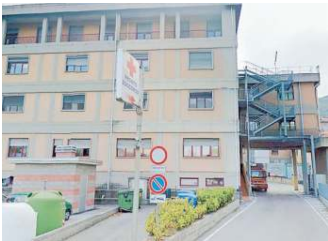
L'accesso al pronto soccorso dell'ospedale di Cairo
