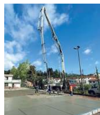
Lavori per il campo da padel
