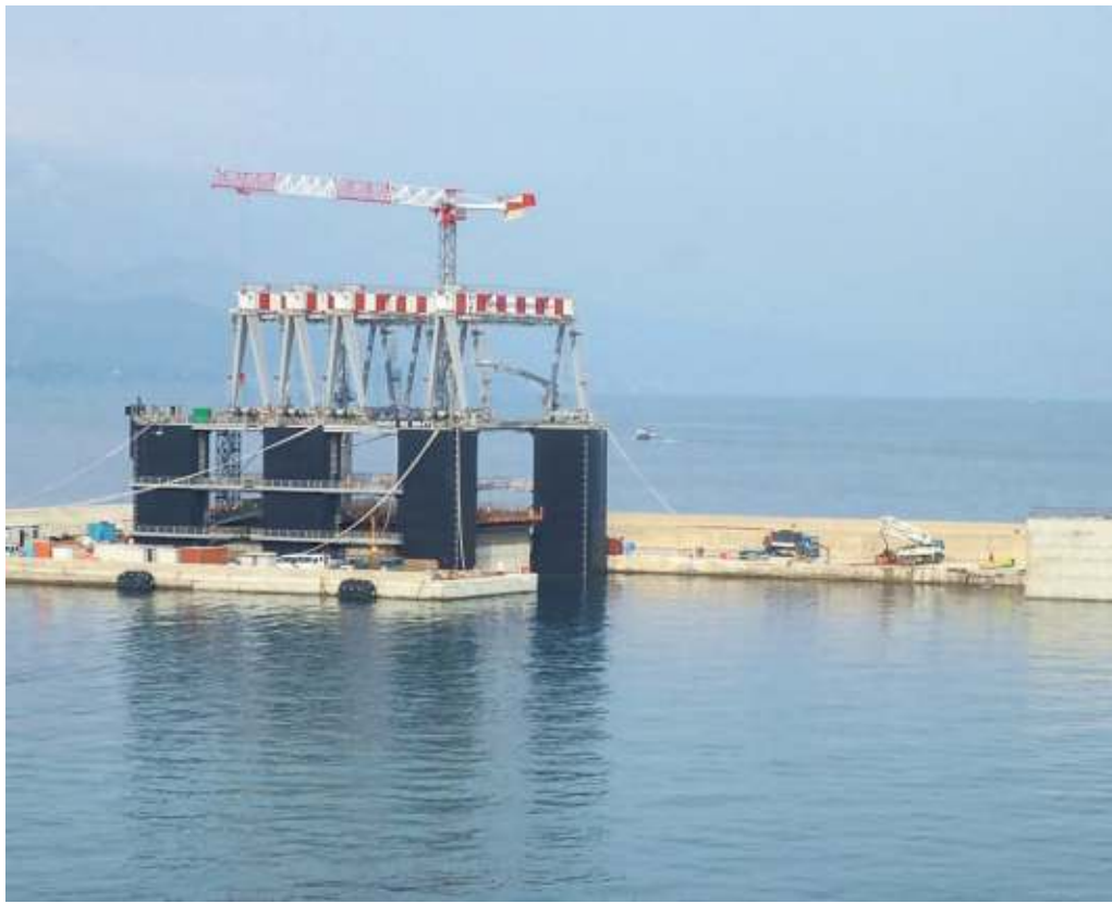
L'impianto esistente nel porto di Vado per la costruzione dei cassoni
