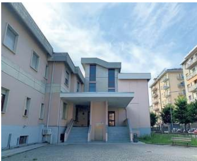
L'ospedale di Cairo interessato dai lavori di adeguamento
