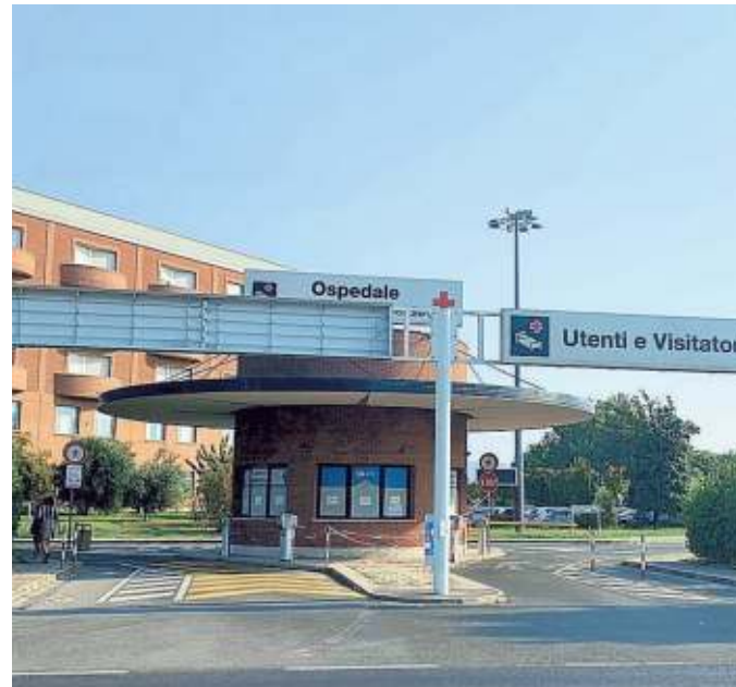
L'ingresso dell'ospedale Santa Maria di Albenga
