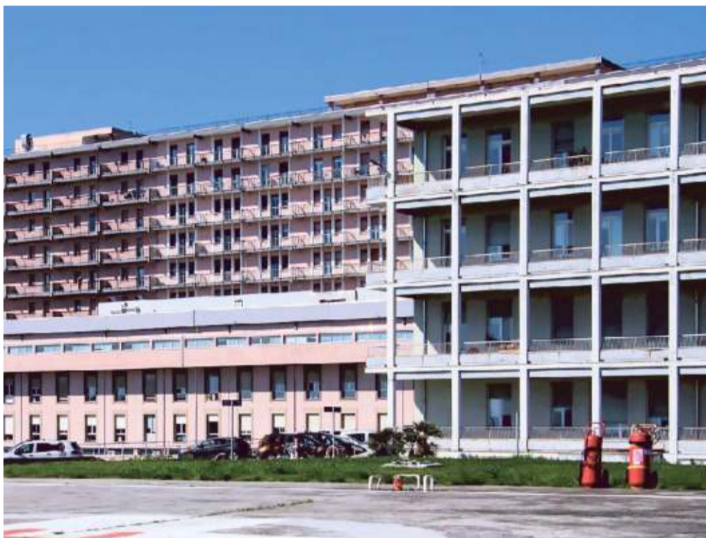
All'ospedale San Paolo è prevista la manutenzione dei balconi della facciata fronte mare
