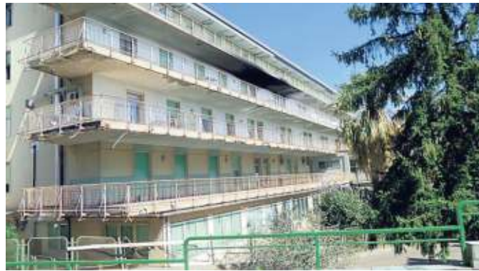
Il padiglione chirurgico dove si è sviluppato l'incendio al terzo piano
