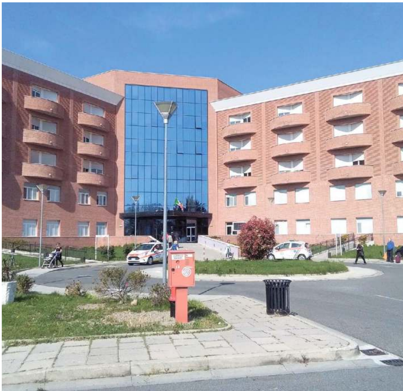
L'ospedale Santa Maria di Misericordia di Albenga, oggi ospedale di comunità, ha ampi spazi liberi e sale operatorie inutilizzate FOTO FRANCHI
