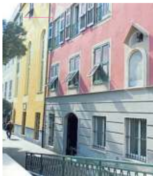
La casa di riposo di Celle
