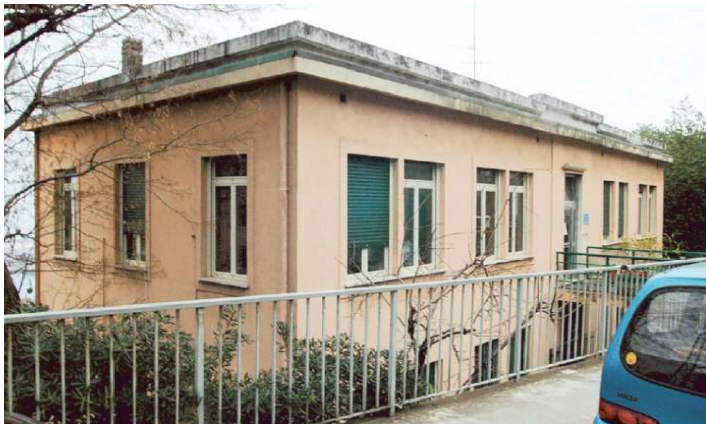
Una delle strutture Asl di via Amendola al centro della protesta degli operatori per l'assenza dell'aria condizionata
