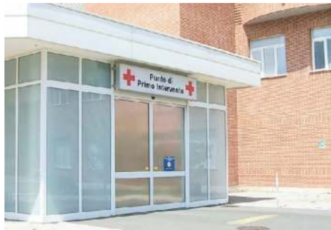
L'ingresso dell'ex punto di primo intervento
