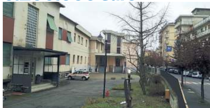
Nuovi servizi al primo e secondo piano del San Giuseppe di Cairo
