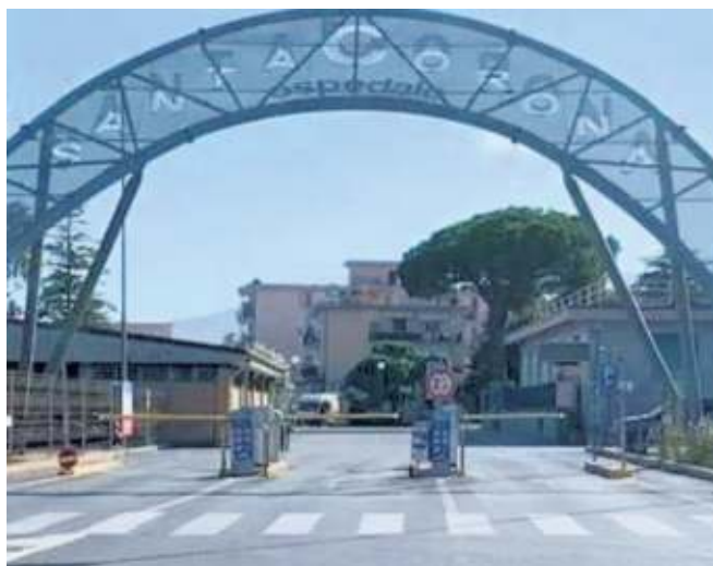
L'ingresso dell'ospedale Santa Corona di Pietra Ligure
