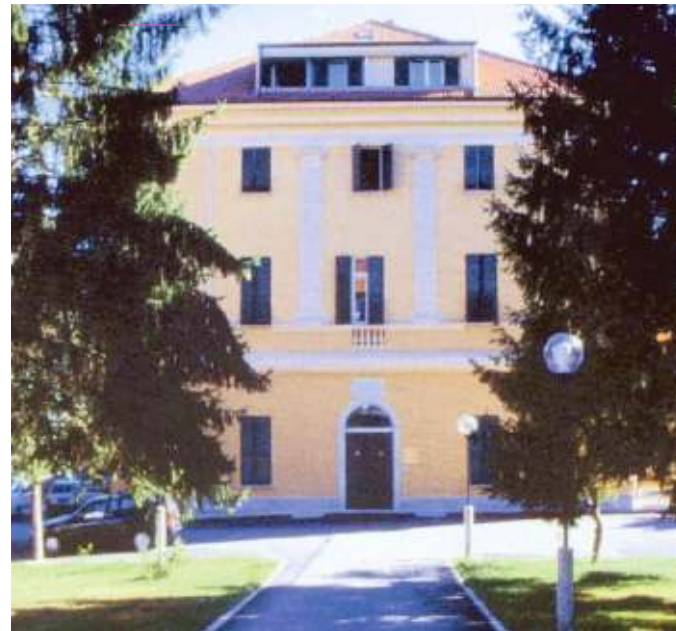
La struttura verrà recuperata e potenziata
