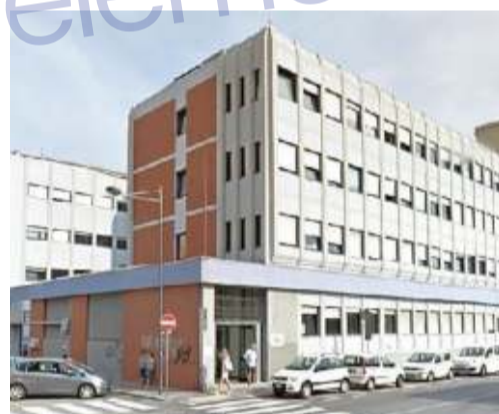
La sede dell'Asl 2 di via Collodi ed alcuni operatori al lavoro
