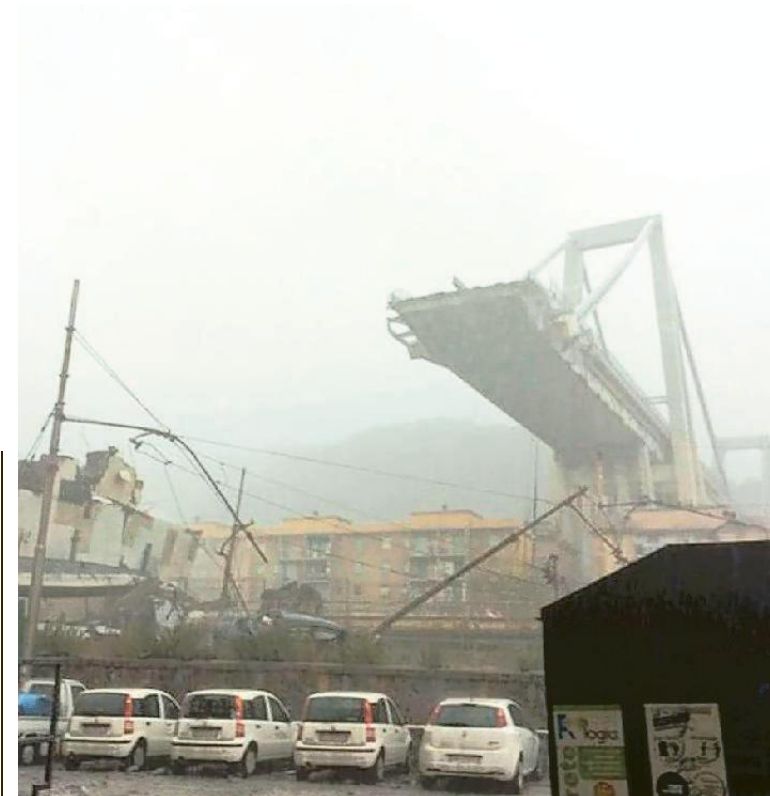
Il Morandi poco dopo il crollo del 14 agosto 2018
