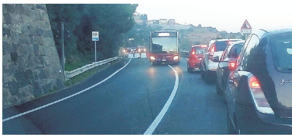
Il cantiere per la messa in sicurezza del versante nel tratto di strada tra Alassio e Albenga
