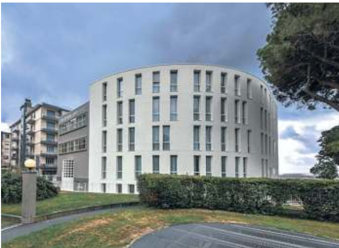
Due immagini della clinica Riviera dopo i lavori durati 2 anni
